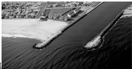
图 1-2 河口护堤引起的泥沙淤积
