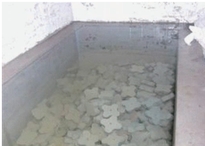
混凝土垫块养护
