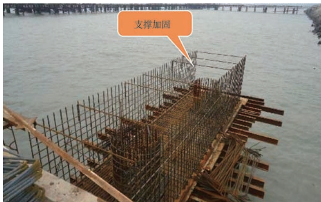
钢筋绑扎及加固
