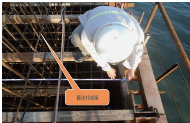
上层钢筋固定
